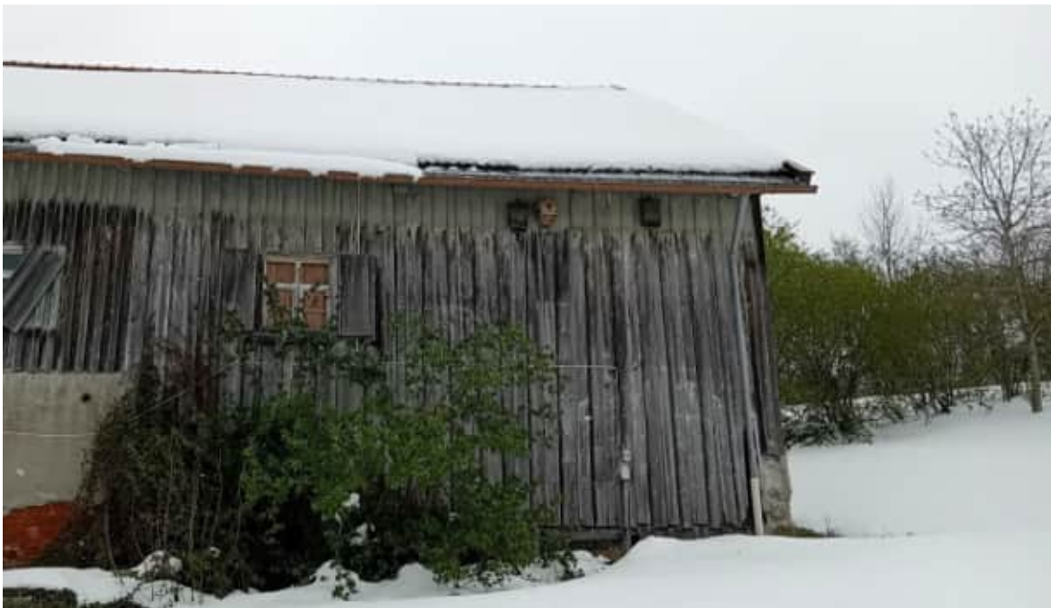
Abbildung 4: Blick auf die Südseite des Gebäudes mit Fledermauskästen und Vogelnistkasten
